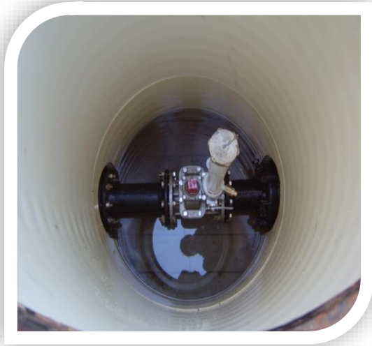
다기능 제수밸브 설치
